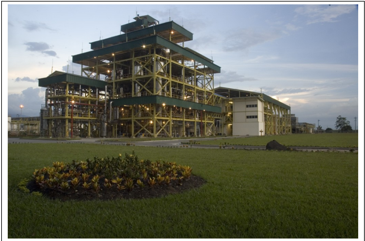
Figura 15. Fotografía de la Destilería de Ingenio Providencia
