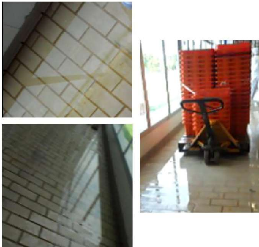
Figura 29. Líquidos condensados generados dentro del área procesos
