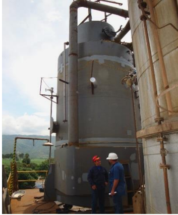
Ilustración 64: Montaje del equipo.
