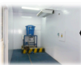
Sistema de recirculación de agua
