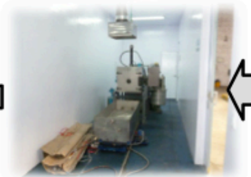
Ups, sistema de extracción – no resultó...
