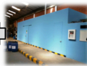
Construcción cuarto de aislamiento
