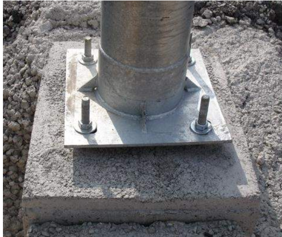
Fig 44. Fundición de Concreto Zapata. Fuente: Pagina web www.larraz.es
