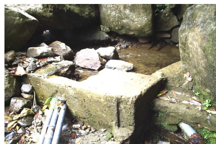
Sistema de captación
