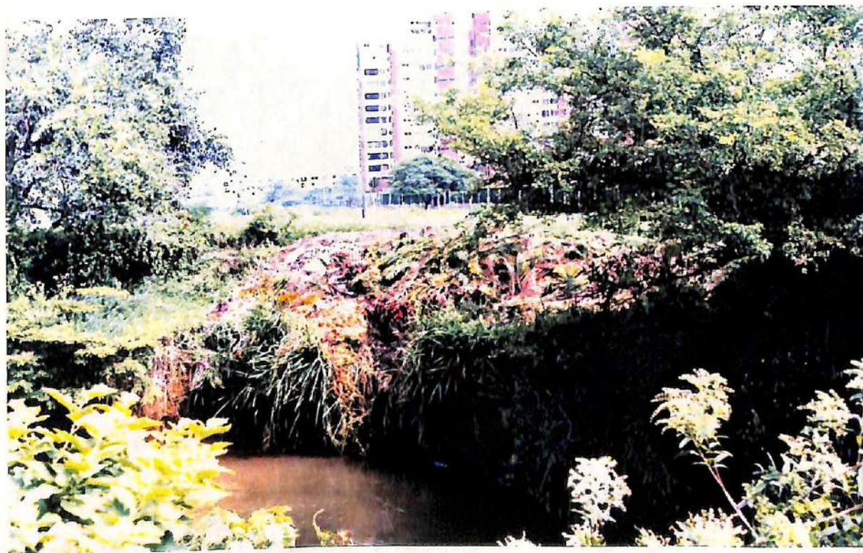
Figura 28. Márgen izquierdo del Rio Meléndez usado como botadero de basura.
