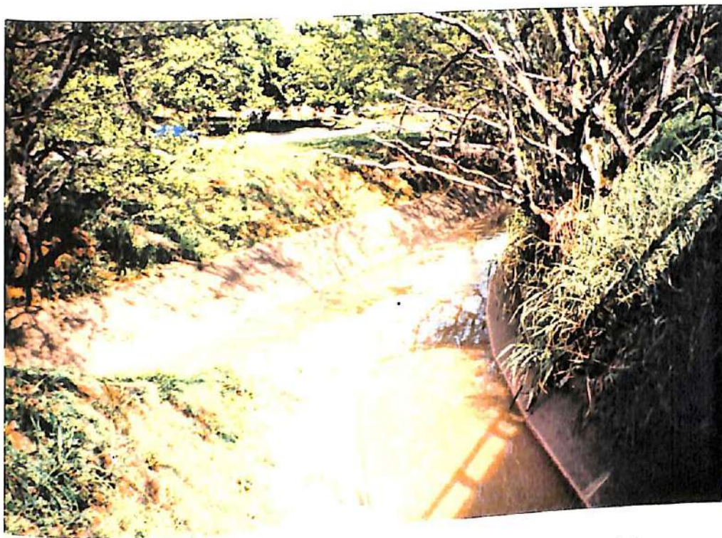
Figura 56. Entrega del colector Carrera 50 al canal Cañaveralejo.
