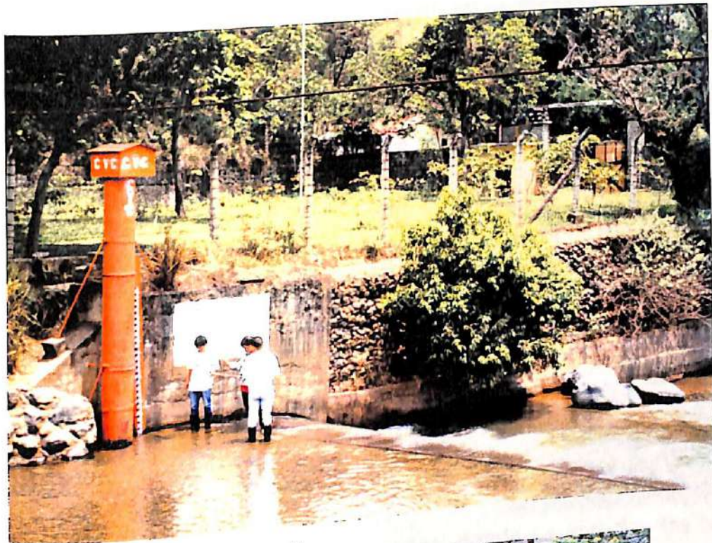
Figura 88. Bocatoma sobre el Río Cali.
