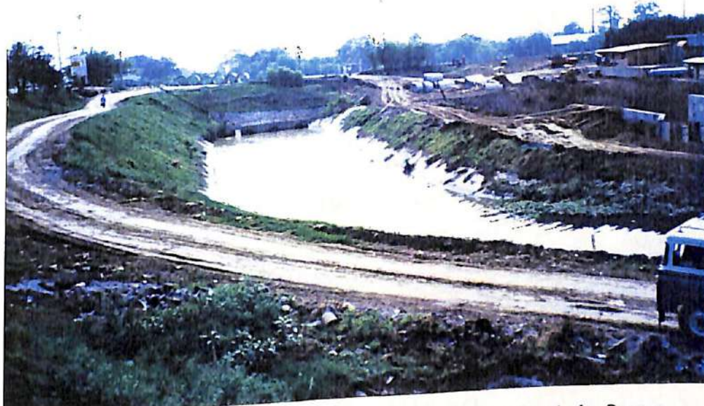
Figura 120. Descarga de la Estación Paso del Comercio al río Cauca.
