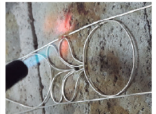
Imagen 24. Soldando estructura de Collum
