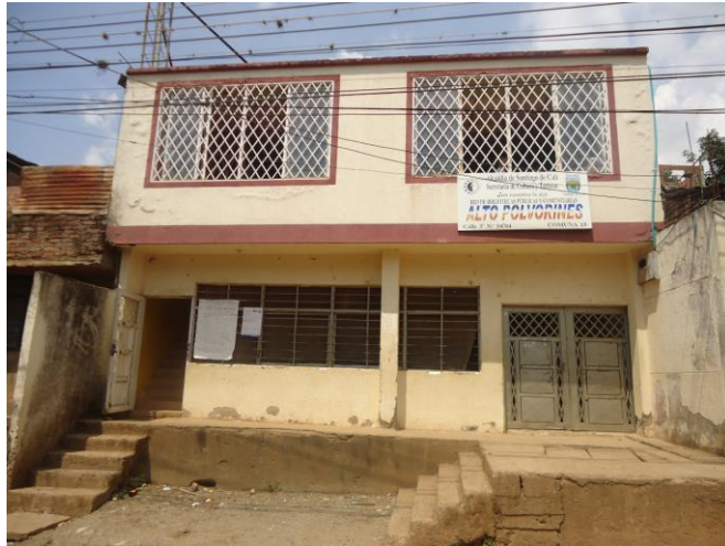
Imagen 1. Fachada de la Biblioteca alto polvorines.
