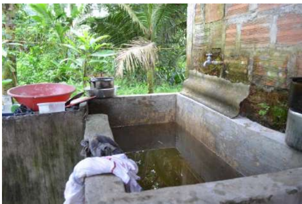
Imagen 26: tanque de cemento
