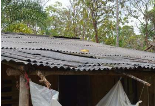
Imagen 2: área de captación, techo.
