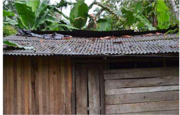
Imagen 3: área de captación, techo.
