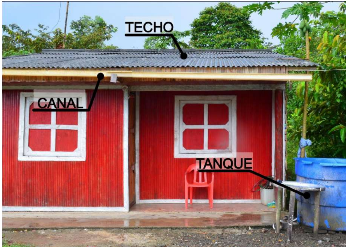
Imagen 1: sistema general de captación de aguas lluvias
