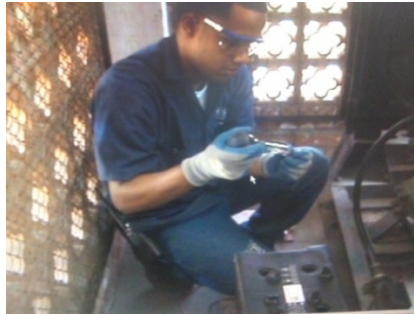
Figura 5. Mantenimiento planta de emergencia edificio A
