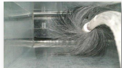
Imagen 3. Limpieza y sanitización de ductos.
