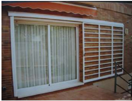
16 Img.16 Ventana Actual con perfiles metálicos. (Ferromax, 2012)
