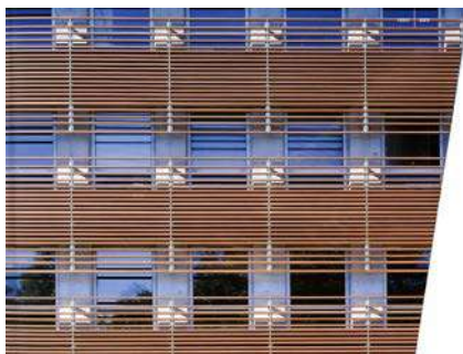
23 Img.23 Fachadas ventiladas (Hunter Douglas, 2014)
