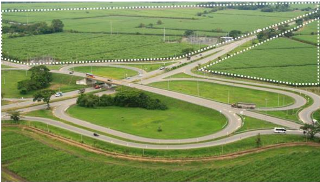
Grafica 4: Puente en Vía Cali- Cavasa
