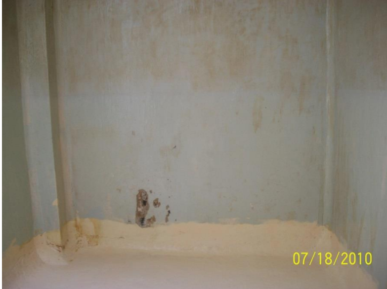
Figura 6 Observaciones durante labores en Espacios Confinado
