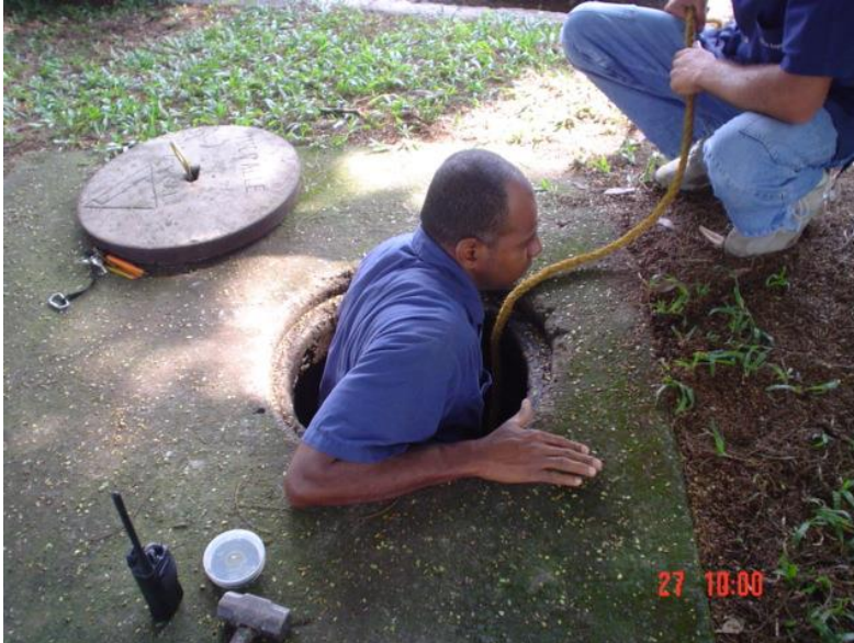
Figura 8 Observaciones durante labores en Espacios Confinados
