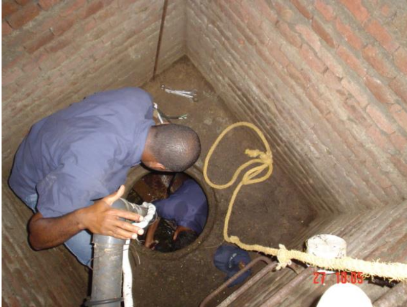
Figura 10 Observaciones durante labores en Espacios Confinados
