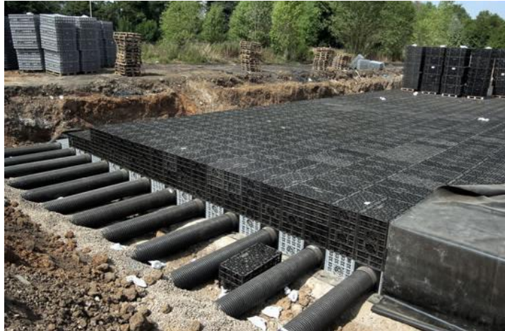
Ilustración 3 Tanques de almacenamiento
