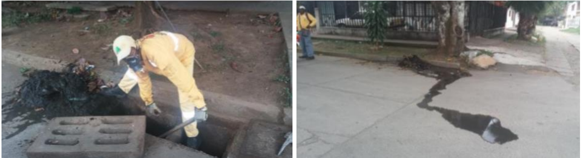
Ilustración 12 Mantenimiento de sumideros
