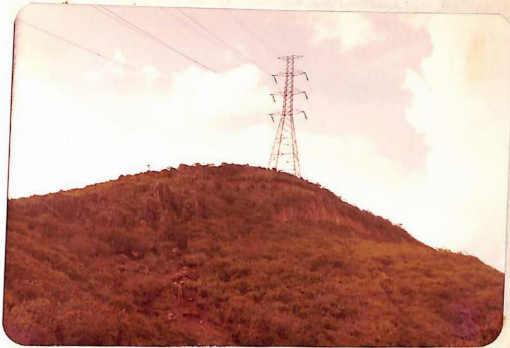
Foto N° 11 (F. Giraldo) Zona Sur de la ciudad de Cali, Alto de La Cruz. Es notable la consecuencia de la acción minera identificable por los socavones, los sedimentos sobrantes superficiales y los hundimientos posteriores del perfil del suelo y el peligro inminente para la torre de redes eléctricas.
