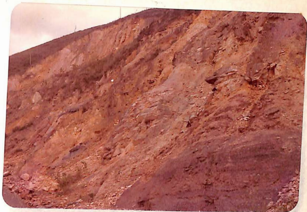
Foto N° 5 (F.M. Suárez) Región de Golondrinas, cuenca del río Aguacatal. Se observan los diferentes estratos sedimentarios con buzamientos fuertemente inclinados en taludes desprovistos de vegetación.
