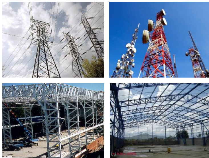
Figura 24. Arriba: torres de energía y de telefonía. Abajo: reticulados de soporte estructural. Fuente: elaboración propia.
