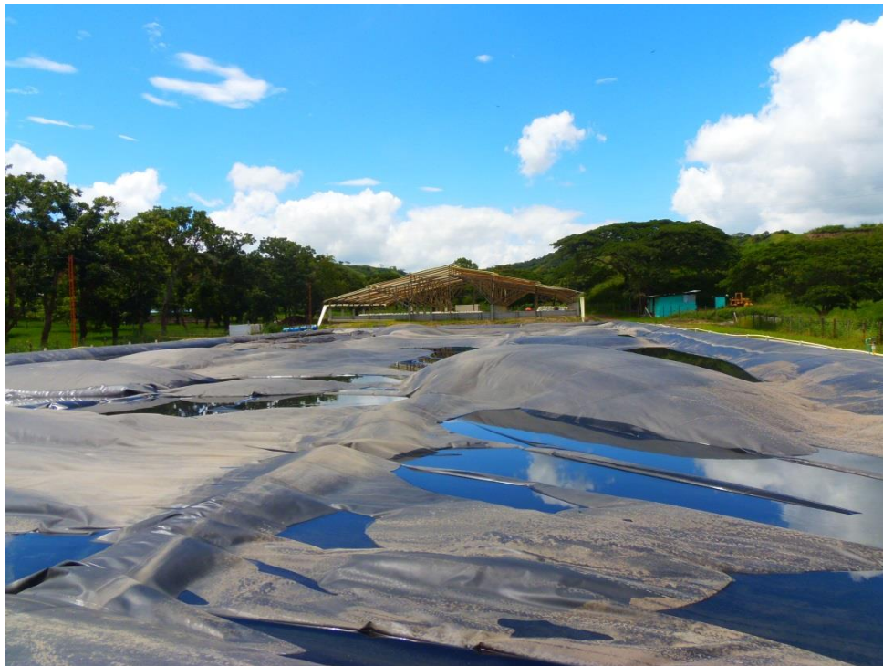
Figura 5 Laguna de Oxidación Anaeróbica Fuente: elaboración propia
