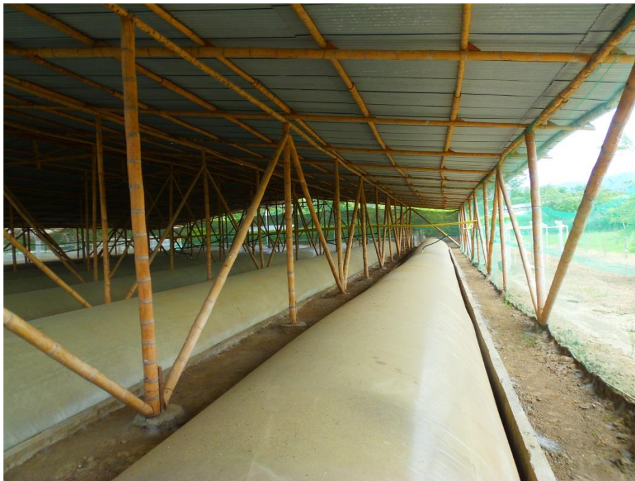
Figura 4 Digestor Tipo Taiwan Fuente: elaboracion propia
