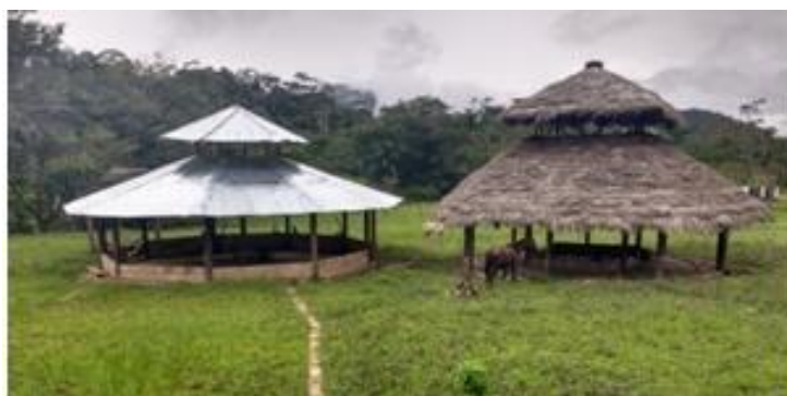
Figura 2. Quioscos en construcción
