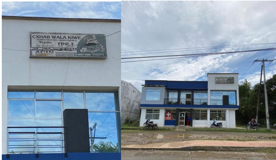
Ilustración 24. Centro de salud administrado por la ACIN
