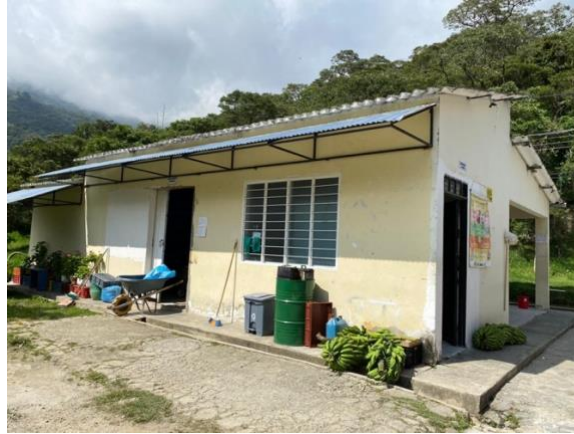
Ilustración 13. Bodega de alimentos de la Unidad Económica Truchas Juan Tama
