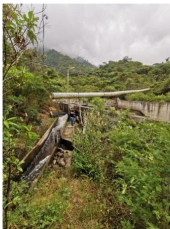
Ilustración 11. Construcción primera etapa de las piscícolas Truchas Juan Tama
