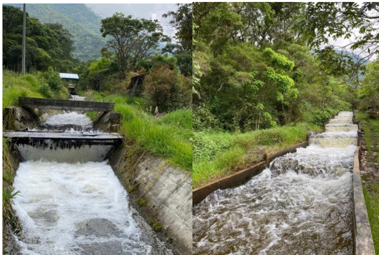
Ilustración 17. Desvío de ríos para abastecer los tanques de la Unidad Económica Truchas Juan Tama.
