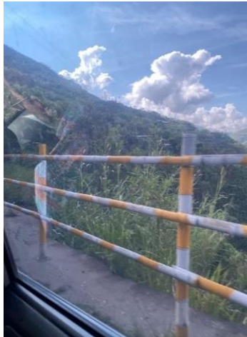
Ilustración 6. Delimitación del espacio por caída de la banca construida por la comunidad
