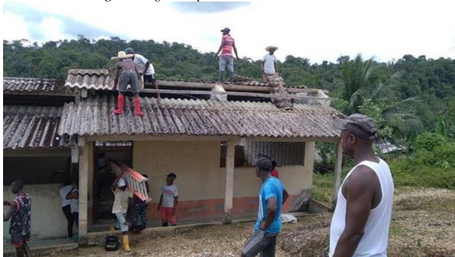
Imagen 1 Minga de Reparación de las Instalaciones Escolares
