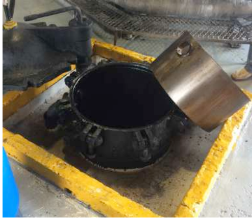
Figura 6. Torre de decoloración Manuelita S.A
