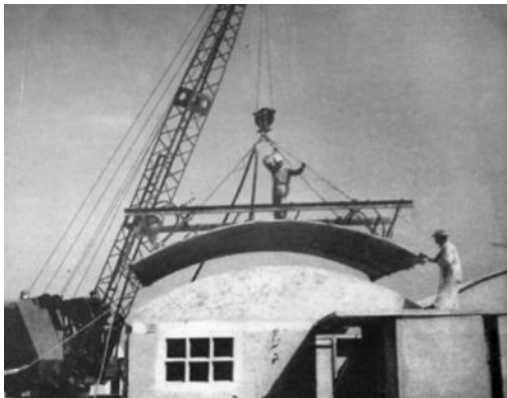
Imagen 27: Álvaro Ortega - Cubiertas laminares en el barrio Quiroga, Bogotá, 1951- 1953 (Billner y Zollman, 1954). Colección personal Cáscaras de hormigón en la arquitectura
