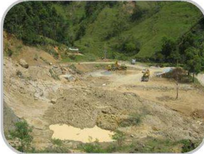
LUGAR DONDE SE UBICÓ LA PLANTA DE TRITURADO
