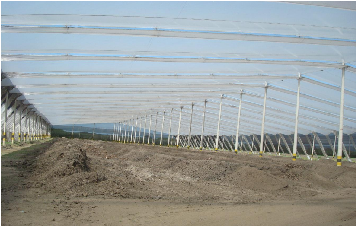
Figura 2. Vista interior de la planta de aprovechamiento Ingenio Riopaila
