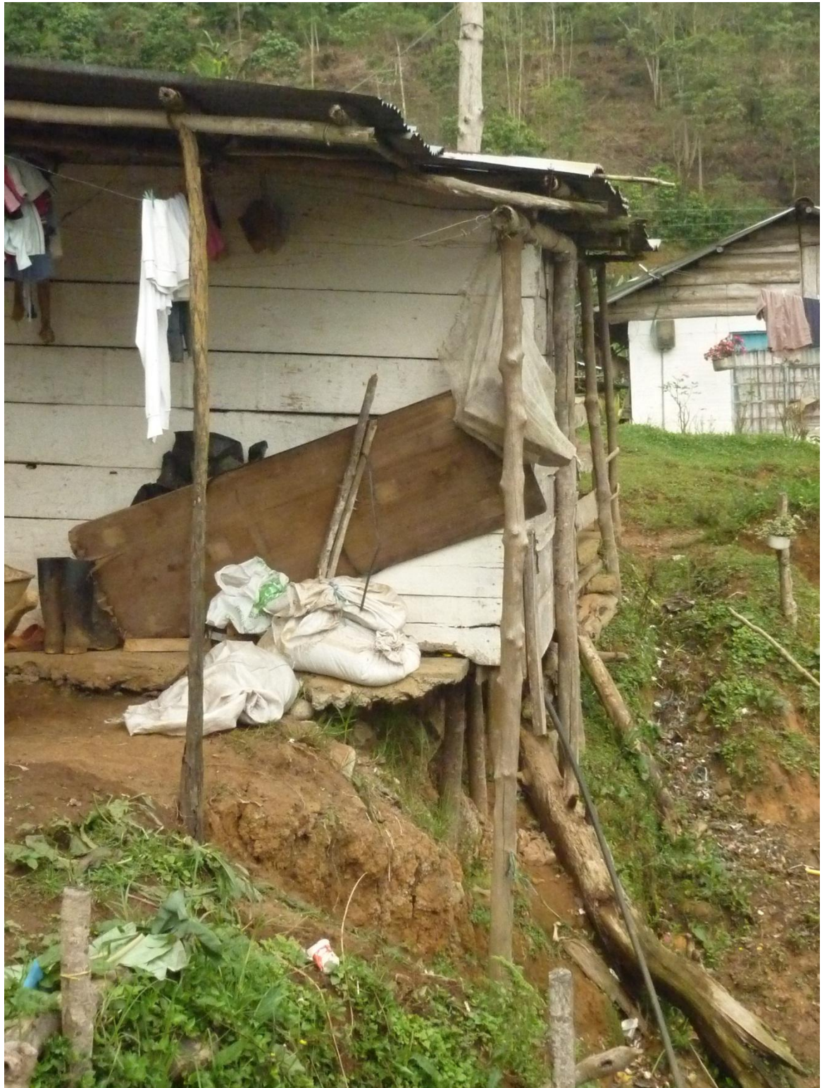
Estructura de una de las casas. Foto tomada por las autoras del proyecto en la vereda La Esperanza
