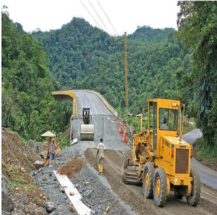
Ilustración 11 Construcción de la vía Cali-Buenaventura.
