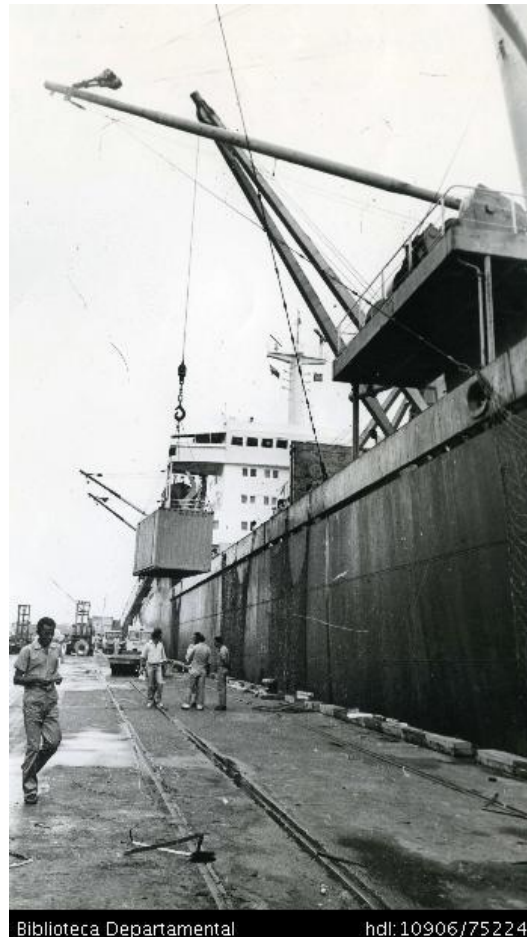
Ilustración 2 Muelle en el puerto de Buenaventura
