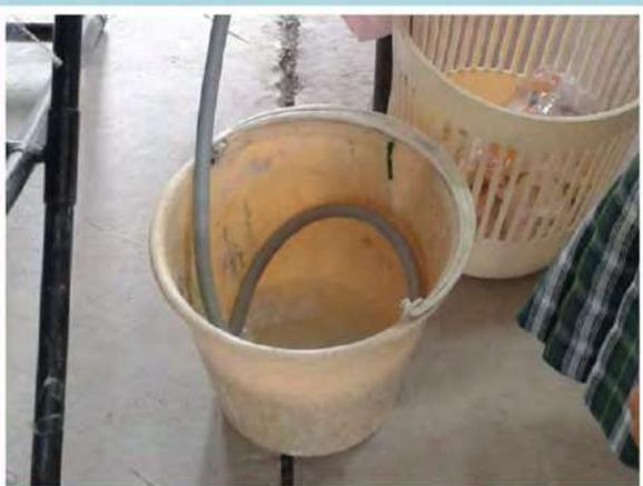
Condiciones inadecuadas del desagüe de la escupidera
