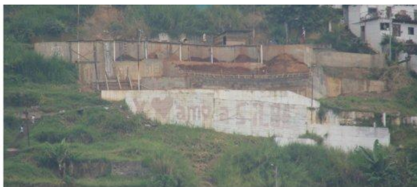
Imagen 1. Lote y muros de contención antes de la construcción del parque. Noviembre de 2008.
