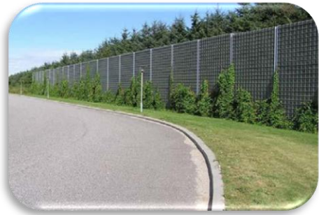
Barreras acústicas desarrolladas con plantas y sustratos, utilizadas para aislar el ruido de las calles altamente transitadas de las zonas aledañas a través de la absorción.
