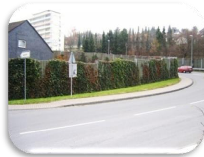
Barreras acústicas desarrolladas con plantas y sustratos, utilizadas para aislar el ruido de las calles altamente transitadas de las zonas aledañas a través de la absorción.
