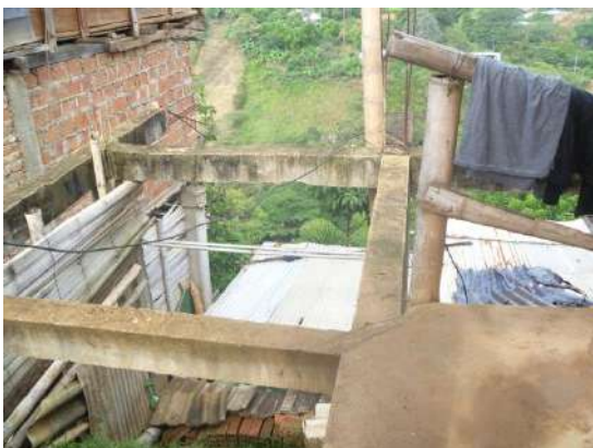
En la foto: Estructuras en guadua, alambre y varilla.
