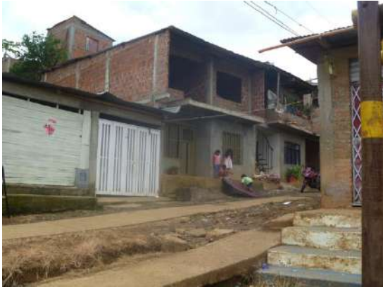
En la foto: Niños jugando con una mesa deteriorada
