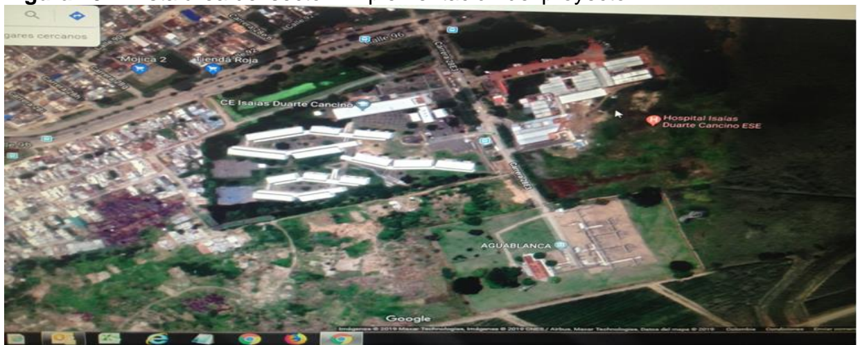
Figura 20 – Vista área del sector- Implementación del proyecto.
