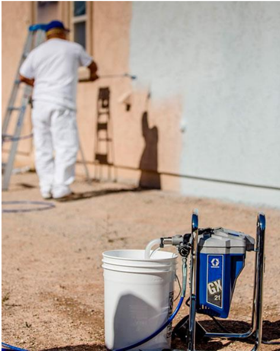
Aplicación de equipos Airless en acabados arquitectónicos.
