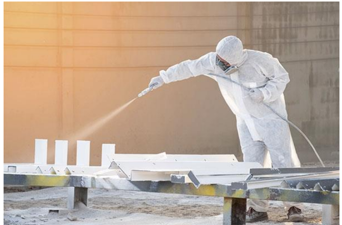
Aplicación de equipos Airless en acabados metalmecánicos (Estructuras).
